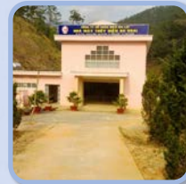
Đa Khai - 2010 37 triệu kWh/năm - 8,1 MW Sông Đa Nhim - 4.568 giờ
